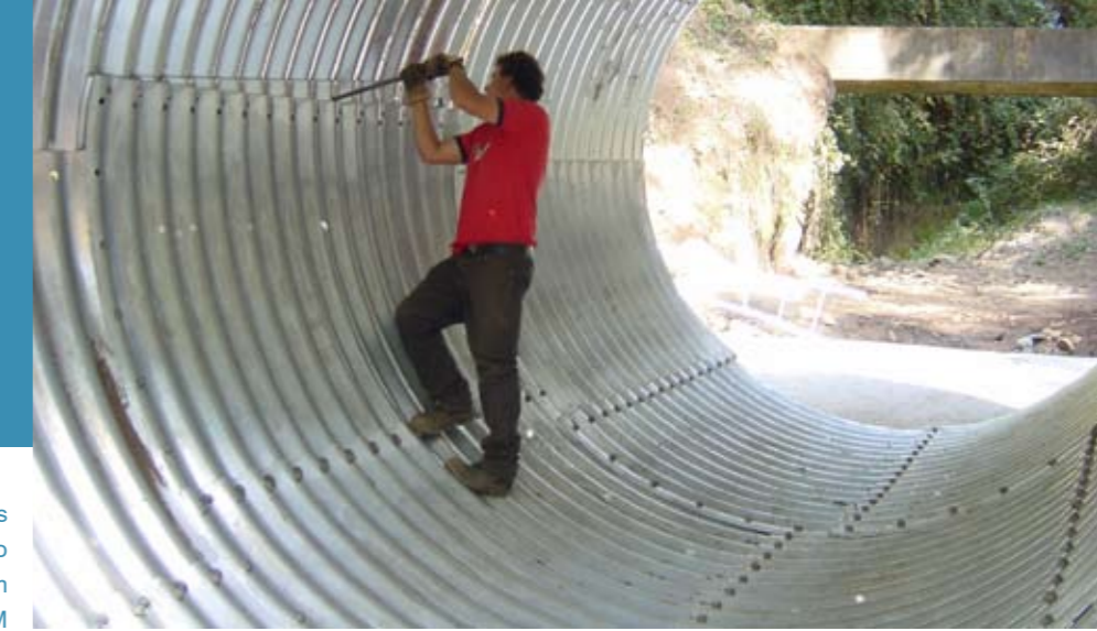
Aproveitamentos de Fins Múltiplos dos Socorridos - Transformação do Sistema de Inverno em Funcionamento Reversível / EEM
